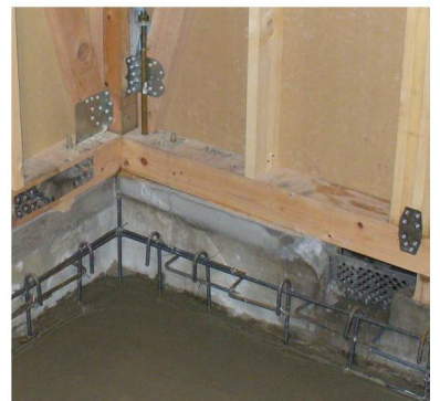
■ 基礎を補強する(施工中)
