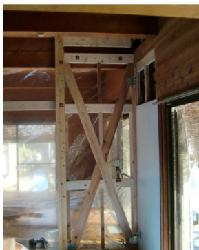
■ 筋かいを入れて補強する
